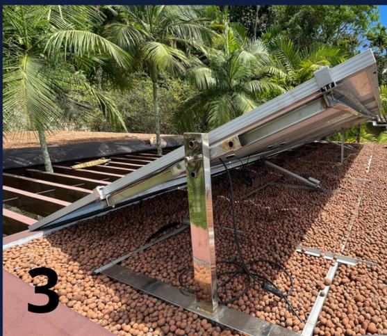
Esse sistema funciona com dois atuadores lineares elétricos, figura 3, que movem a estrutura até uma angulação de aproximadamente 70 graus no sentido do por do Sol e 30 graus no sentido do nascer do Sol.
