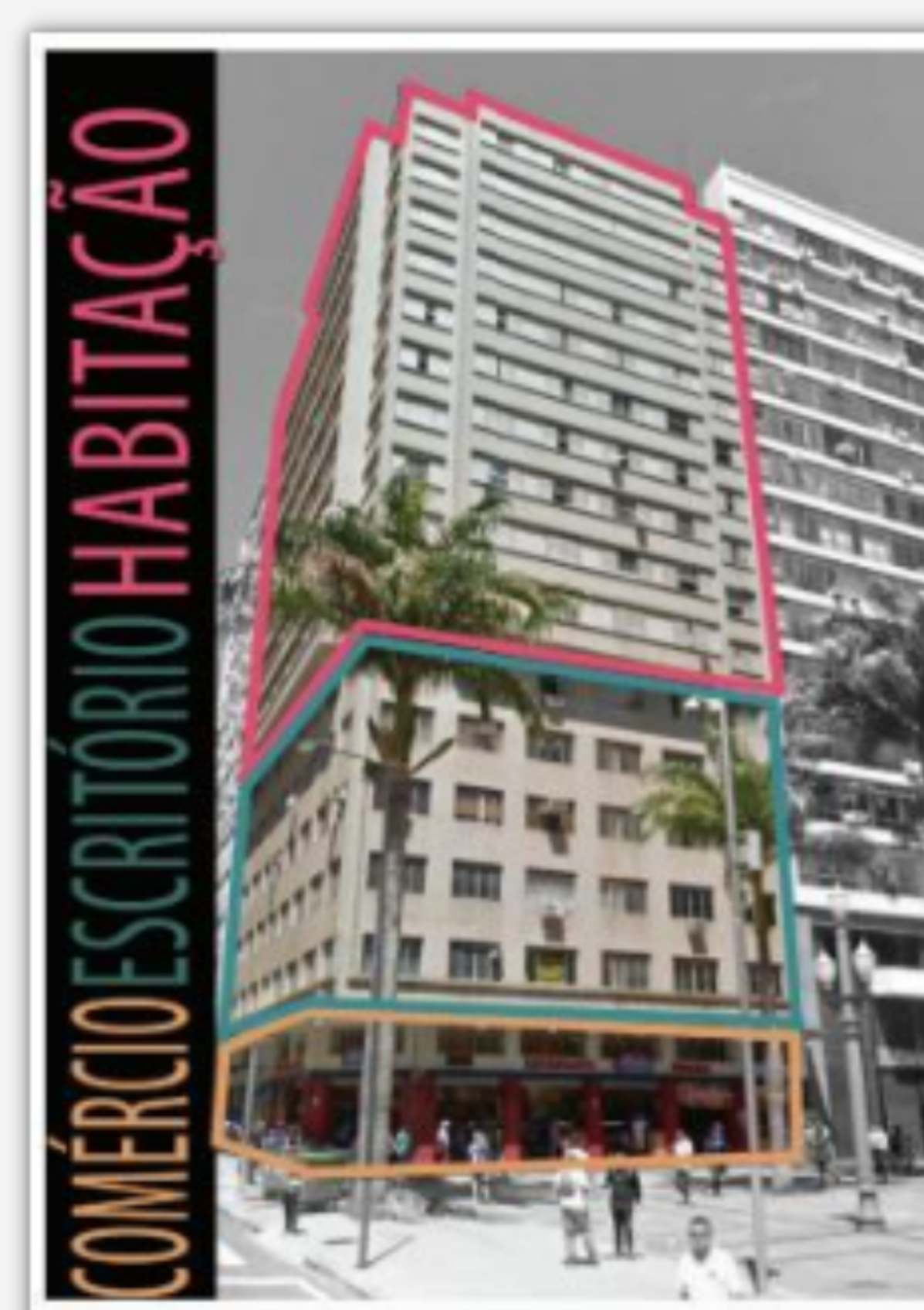
Figura 3: Setorização evidente da fachada do Edif. Catedral
