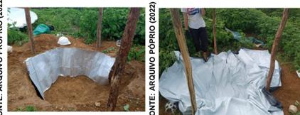
Após cavar o reservatório, o mesmo foi revestido com uma parede de caixas de leite e em seguida com lona, para manter a água reservada limpa.
