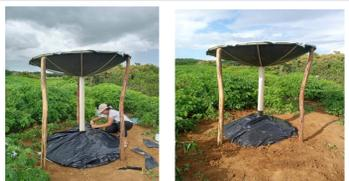
Foram colocadas as estacas, o reservatório foi coberto por uma antena, o cano foi conectado a outra antena virada para cima para captar a água e o sistema foi concluído.
