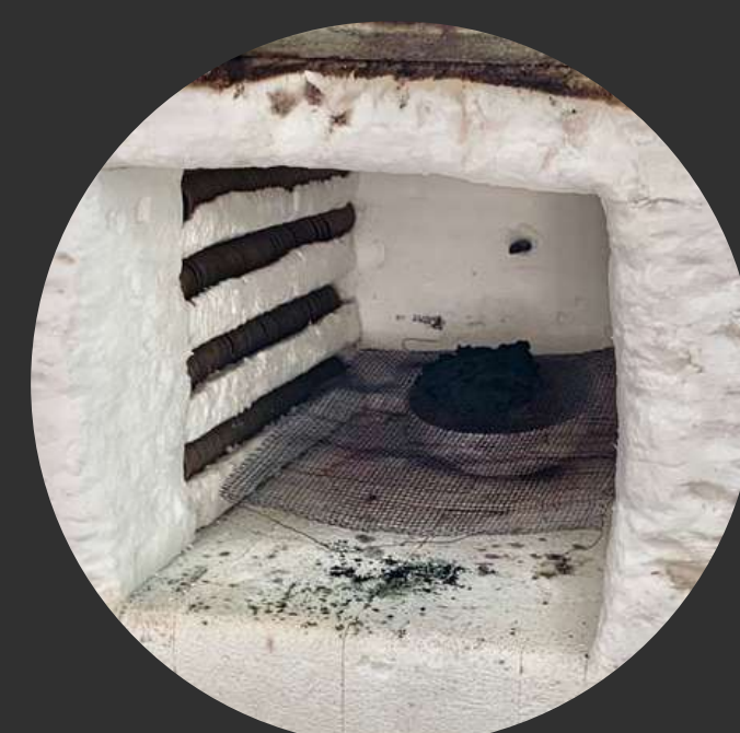
Revestimento com silicone
