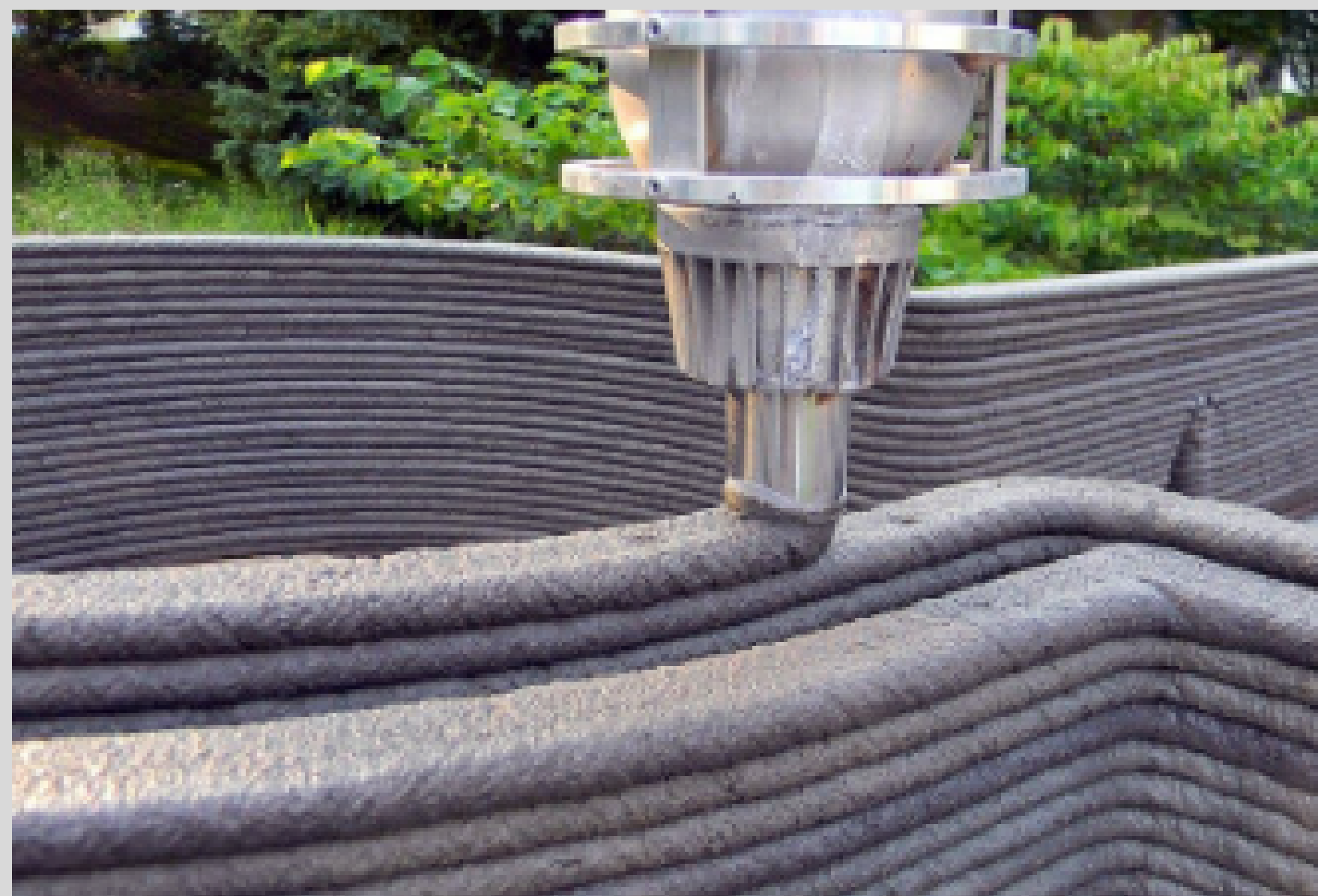
Figura 1 - Construção civil utilizando uma impressora para material de concreto; Fonte: cimentoitambe, 2021.
